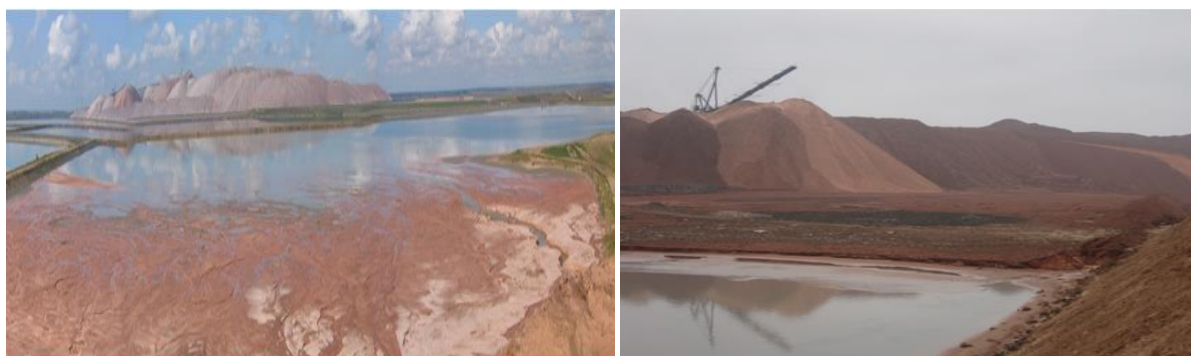
Рисунок 3. Реализация складирования солеотходов на отработанное шламохранилище ЗРУ ОАО «Беларуськалий»
