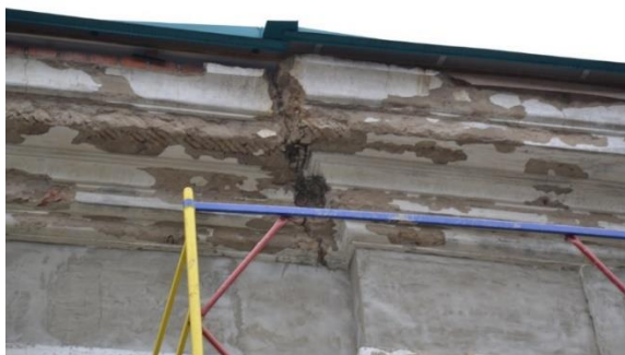
Рисунок 1. Деформационные трещины в крыше главного корпуса.
