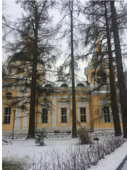
Рисунок 1. Северный фасад церкви Рождества Пресвятой Богородицы (фото Д. Шубиной, 2019).
